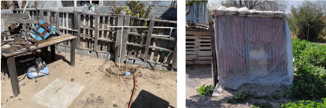
Figura 2 FOSA SEPTICA Y LETRINA EXISTENTES EN EL ÁREA DEL PROYECTO
