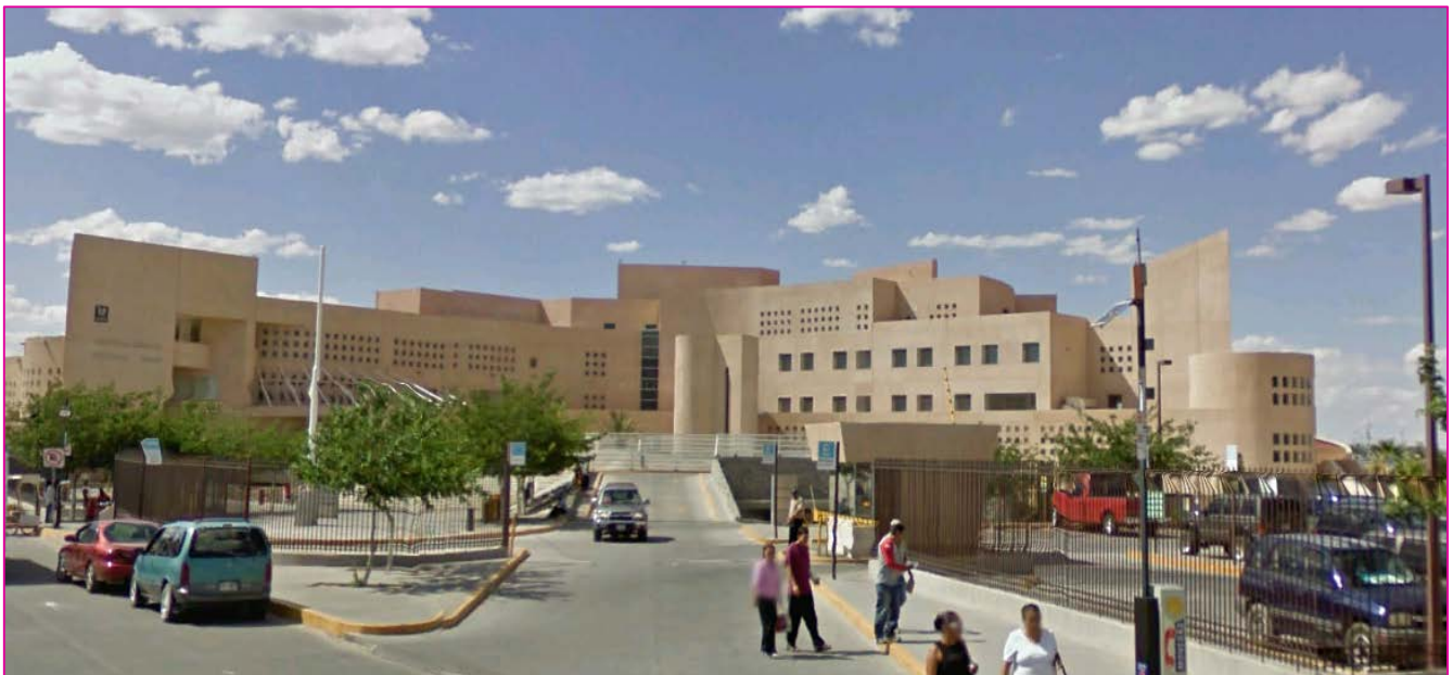
Ilustración 2. Aspectos generales de las fachadas del hospital.
