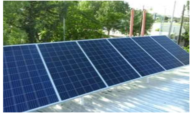
Instalación de paneles solares en el techo de EcoCasa
