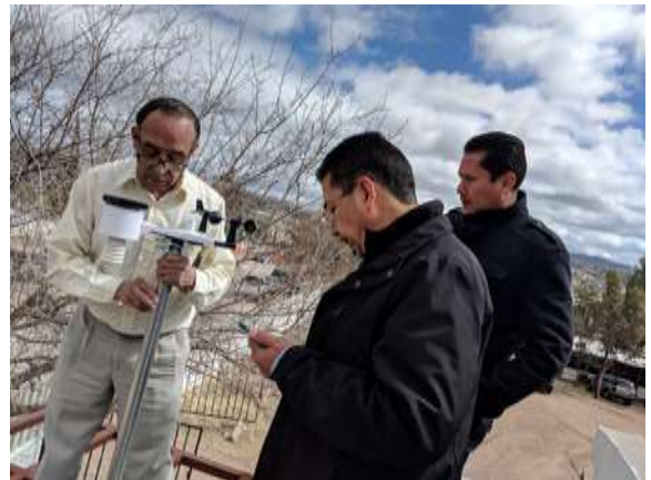
Supervisión de la instalación de monitores ambientales
