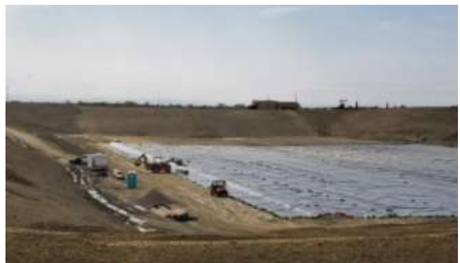
Instalación del revestimiento de geomembrana
