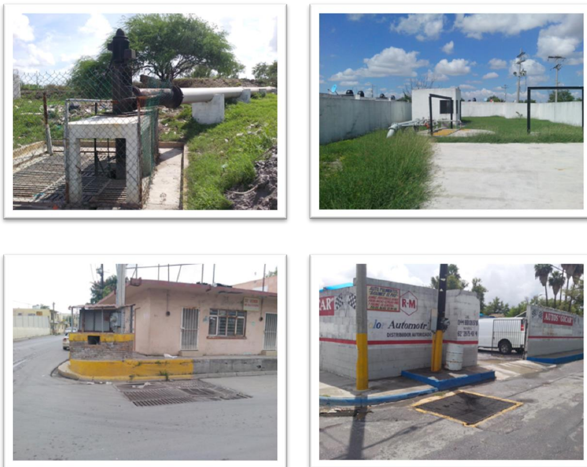
Figura 218. Estado de conservación de las estaciones de bombeo de aguas negras
