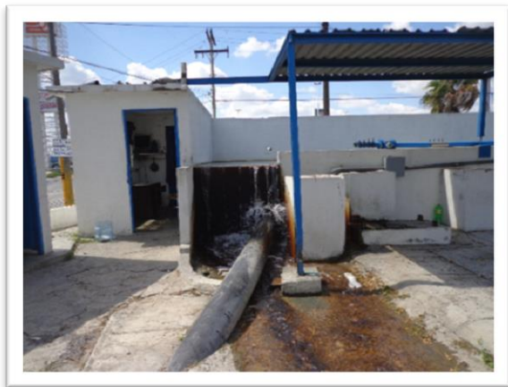
Figura 108. Vertedor del canal de cloración (antes del ingreso a los filtros)
