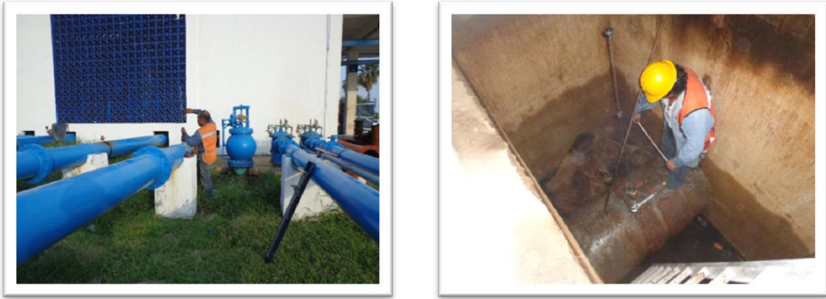
Figura 89. Salida de la bomba 1 a Tanque 3 y de las bombas 4, 7, 8, 9 y 10 a red por línea de 30"
