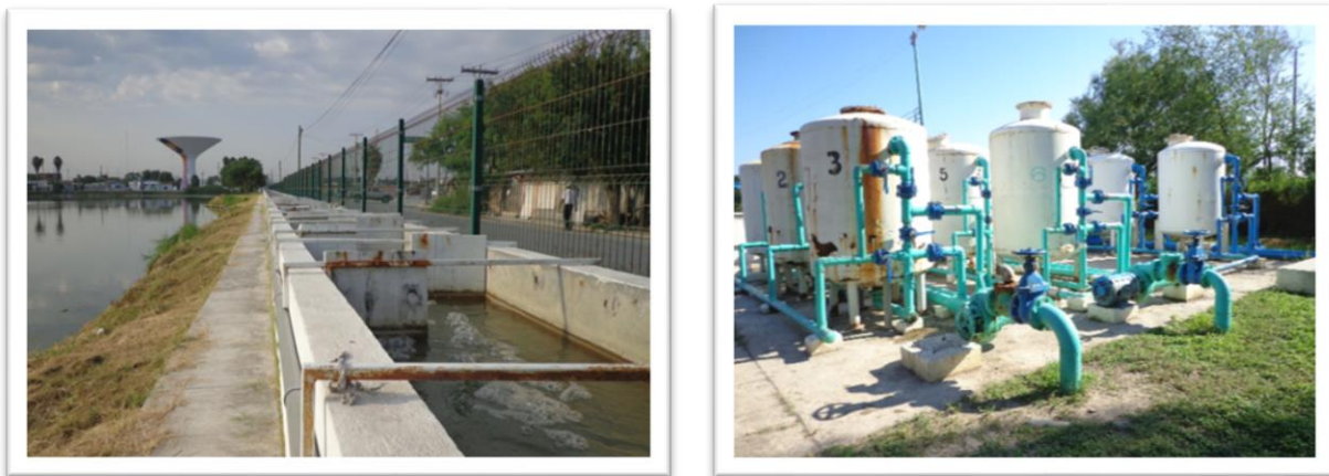
Figura 78. Planta Potabilizadora Paquete 1 y 2
