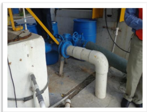
Figura 102. Líneas de ingreso a la Planta Potabilizadora Paquete 1
