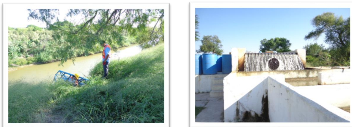
Figura 63. Obra de toma No. 2
