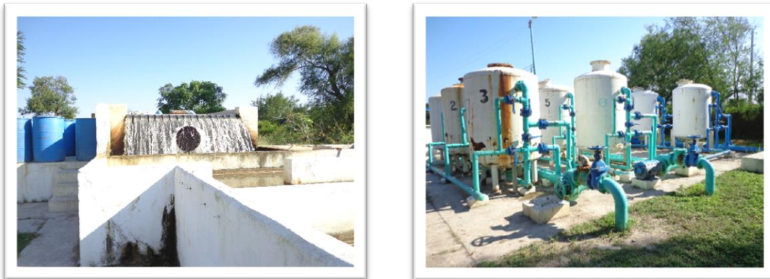
Figura 109. Línea de ingreso a la Planta Potabilizadora Paquete 2 y zona de filtros
