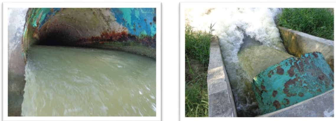
Figura 62. Descarga de la línea a las lagunas de pre sedimentación
