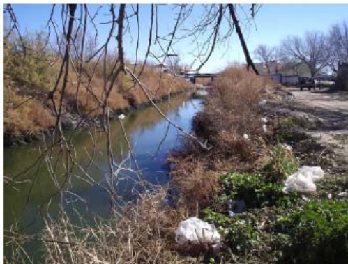
Figura 2. Descarga de agua residual al Dren Interceptor
