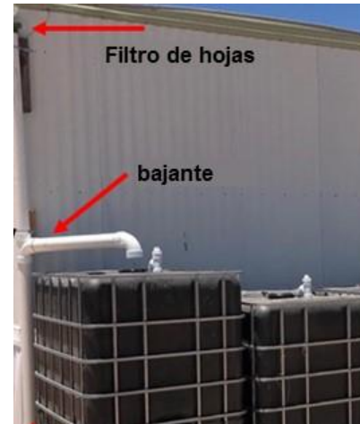
Componentes de un sistema de recolección de agua pluvial
