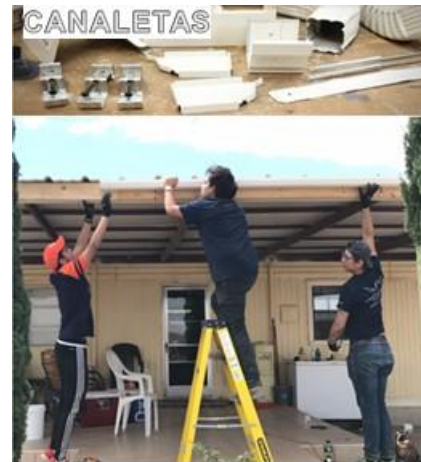
Colocación de canaletas
