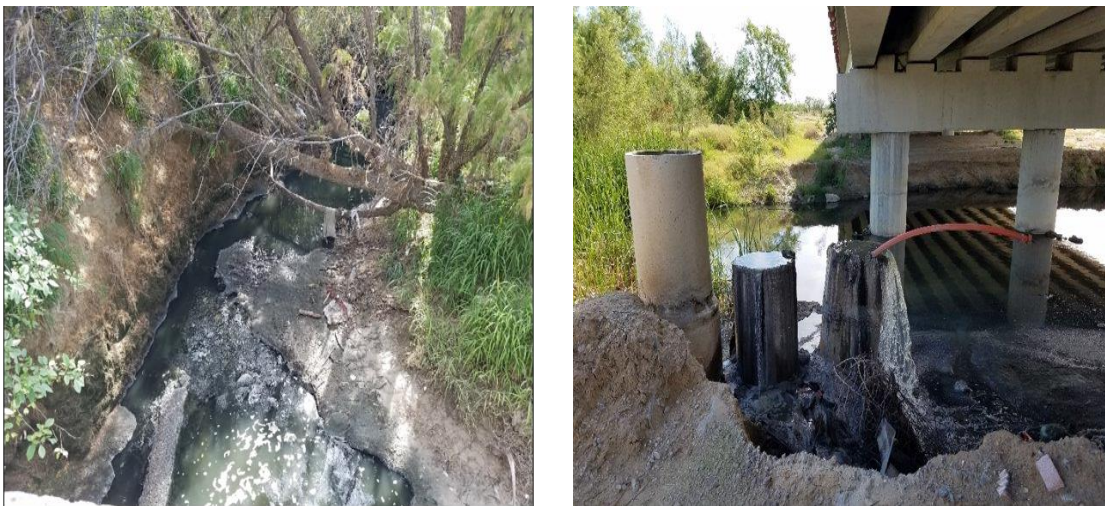
Figura 3 DERRAMES DE AGUAS RESIDUALES AL ARROYO EL COYOTE
